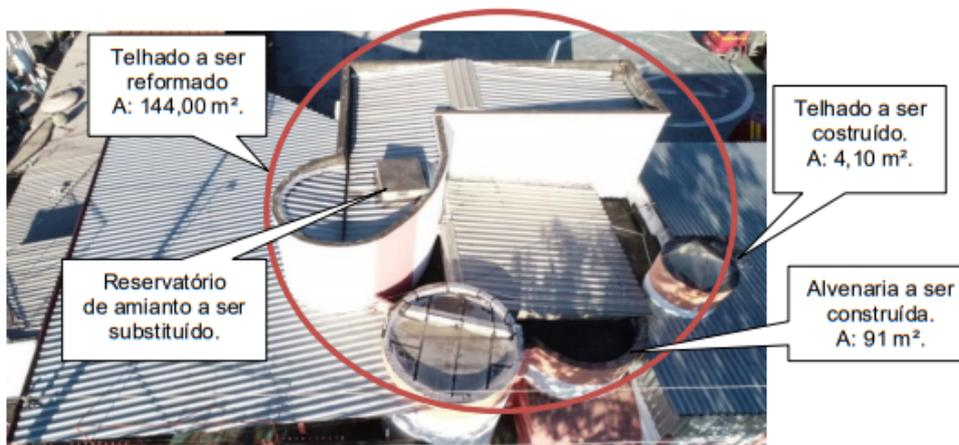
Fotografia 2: Detalhe aéreo do telhado a ser reformado.
